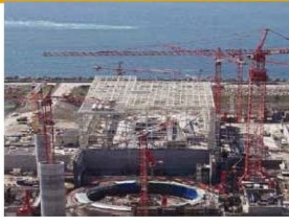
Rys. 2. Widok budowy reaktora EPR – Flamanville (za zgodą AREVA)
